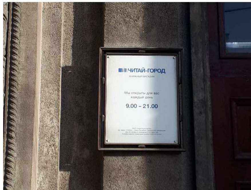
❗ Непрозрачная фасадная табличка по ширине больше, чем простенок. Металлический каркас слишком массивен и неуместен на здании ОКН
