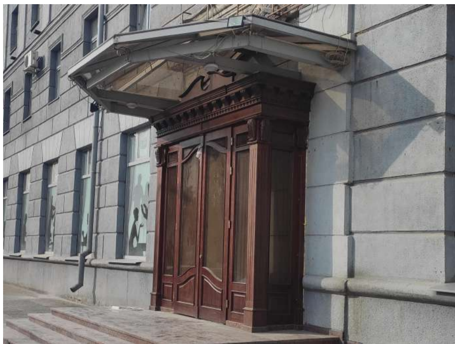
❌ Козырек и входная группа не сочетаются с архитектурой здания. Многоугольная форма козырька нарочита и не вписывается в стилистику объекта
