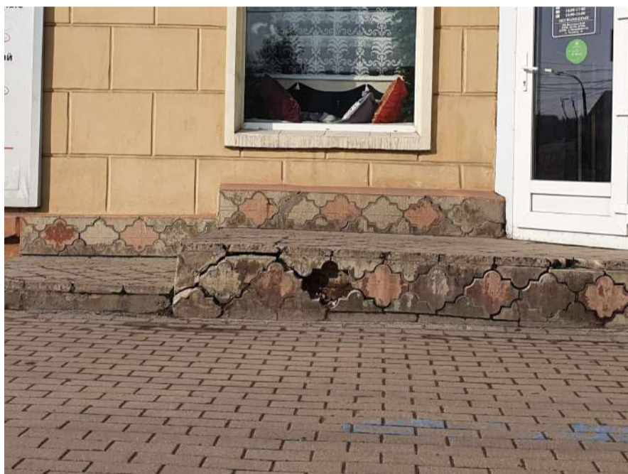
Отделка цоколя тротуарной плиткой недопустима
