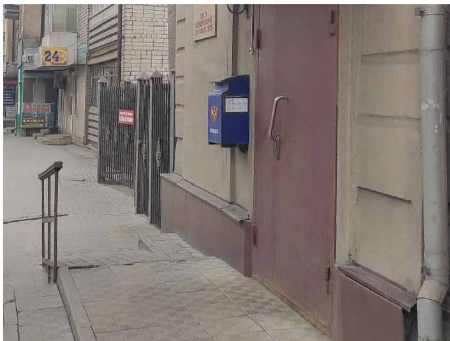
Недопустимое небрежное исполнение отделки цоколя керамогранитом на здании ОКН
