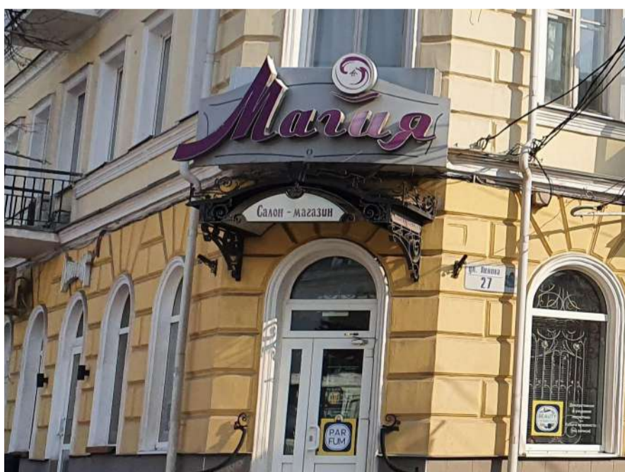
✅ Козырек хорошо сочетается с архитектурой здания ❌ Нависающая конструкция вывески разрушает этот эффект, смотрится дисгармонично
