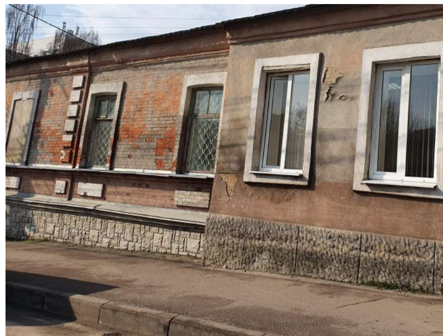
Отделка цоколя данным типом плитки не сочетается с фасадом. Недопустимо отделять разными материалами цоколь одного здания
